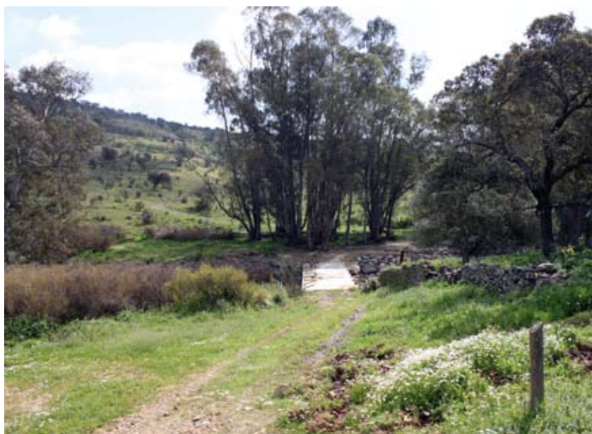
Paso sobre el arroyo del Caño
