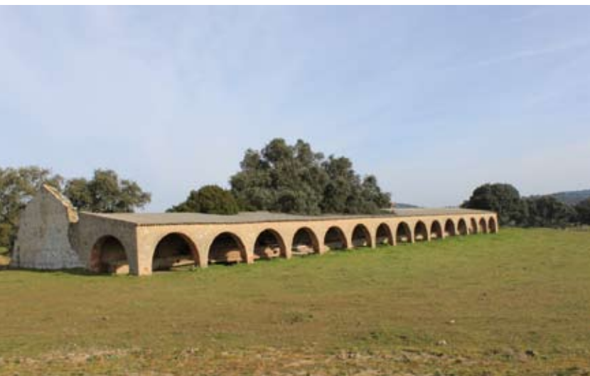
Establos alargados con cubierta
